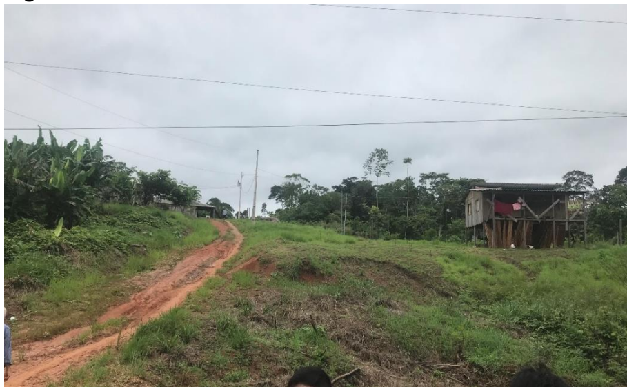
Figura 113 – Erosão na entrada da aldeia Varisko .
