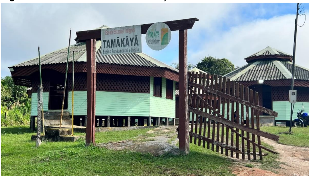
Figura 8 – Vista da Escola Yosite Tamãkayã em maio de 2022.
