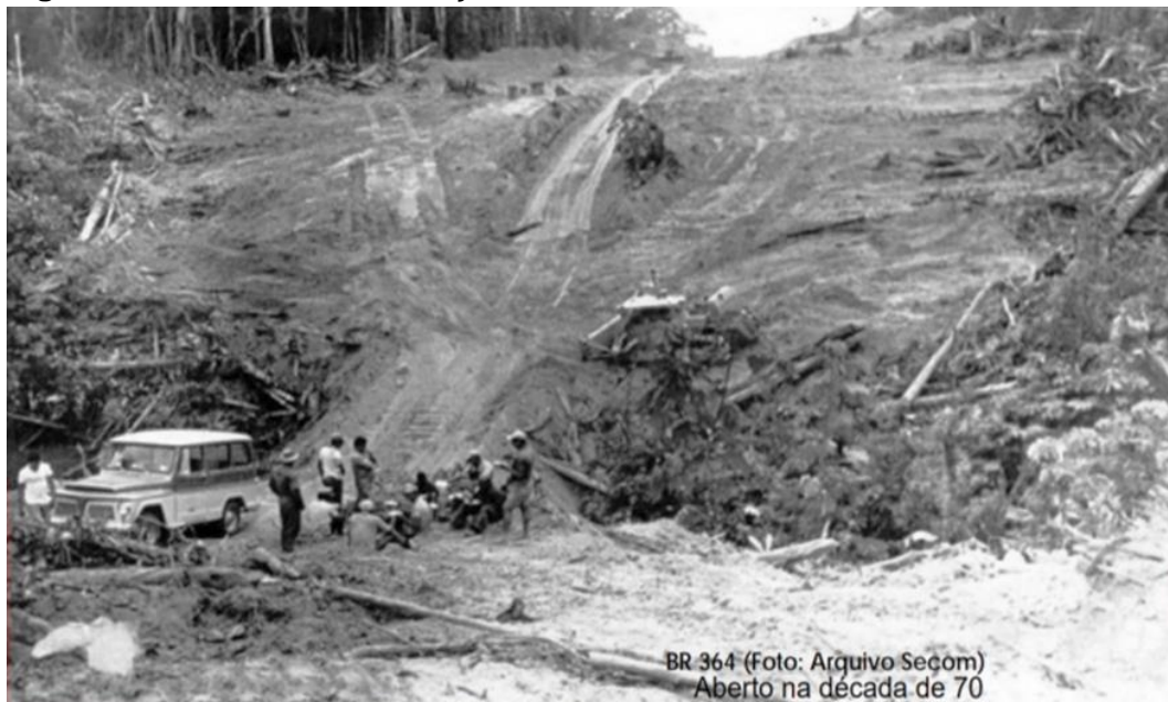
Figura 21 – Abertura e construção da BR-364 na década de 70.
